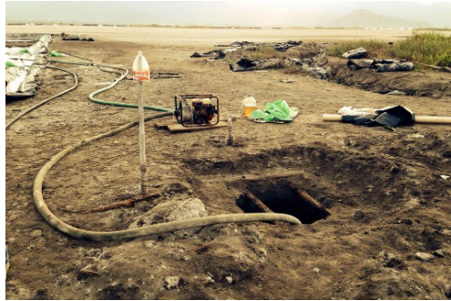
Imagen 35 Extracción de agua con bombas
