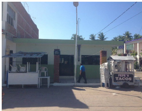
Imagen 6 El edificio que sirvió como clínica
